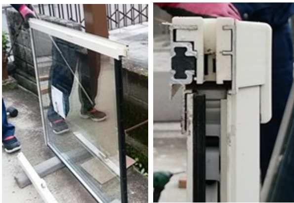
アルミ建具枠を外して新しいガラスに入れ替える。Low-E ペアガラスなので鏡のように物が二重に写っている 建具枠を外した断面詳細。シルバーの部分はアルミ。断熱性の良い白色のプラスチックで内外のアルミ材を分離している
