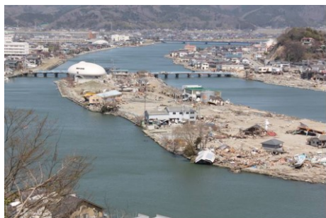
写真3 石巻市内の河川流域での被害状況(同日)
