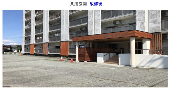
共用玄関 改修後
