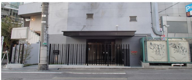
写真2 恵比寿エントランス 豆砂利洗い出し・ロートアイアン
