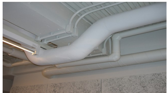
写真5 北参道室内 天高・配管露出 配管・ダクト露出
