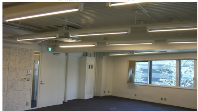
写真4 北参道室内 天高・配管露出 スケルトン天井
