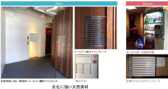
写真1 北参道エントランス 豆砂利洗い出し・木(間伐材)・コルテン鋼
