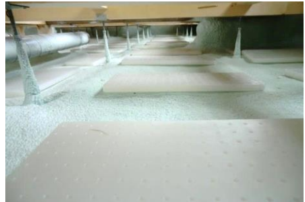
写真1 床下に敷設されたシリカゲルと潜熱蓄熱パネル
