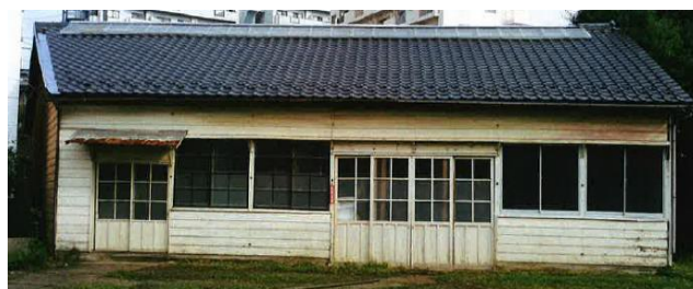
写真 1 改修前の建物（南面） 1)
