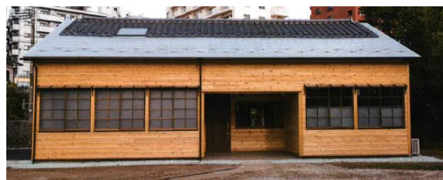
写真 2 改修後の建物（南面） 1)
