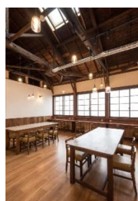
写真3 小屋組みを現わした内部空間
