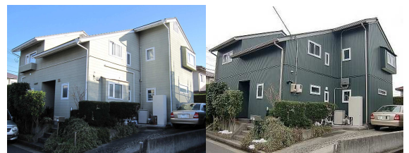
写真1 改修前後の外観(北面より) 【左:改修前、右:改修後】
